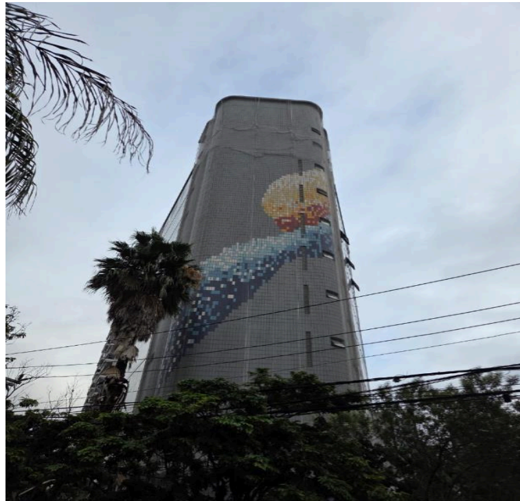
Figura 3 – Fachada Lateral Esquerda.
