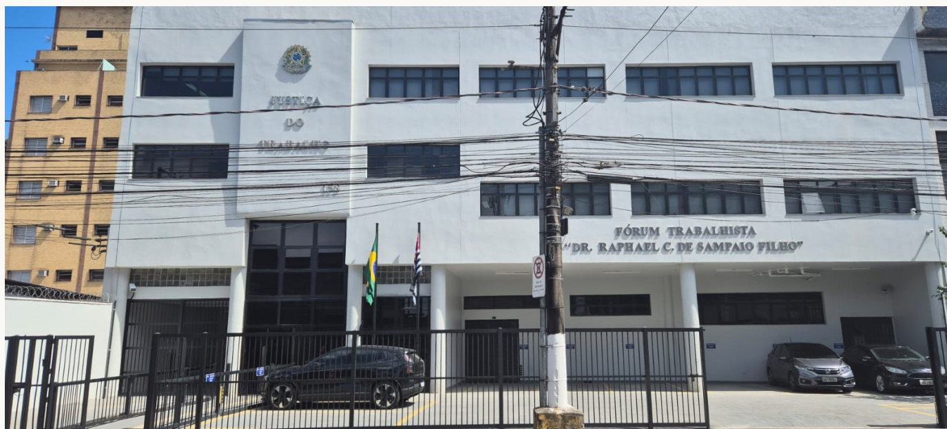
Fórum Trabalhista de Santos: modernização de sistemas e ambientes.
